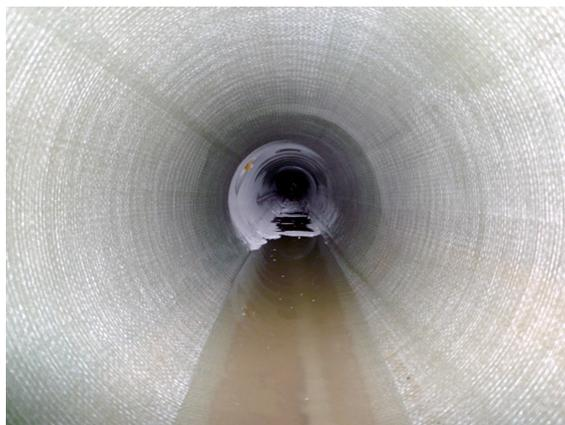
写真-2 施工後管内状況 (穿孔後)
