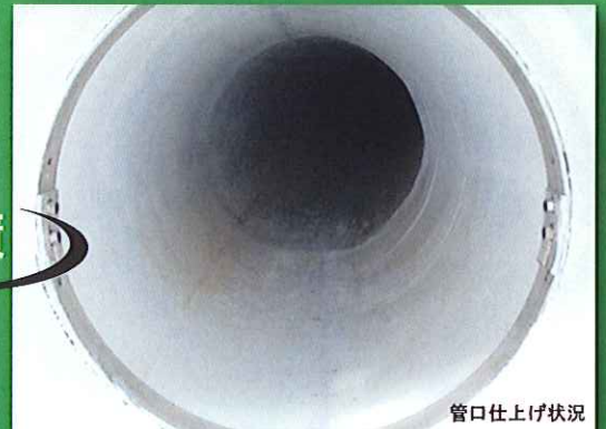
管口仕上げ状況
