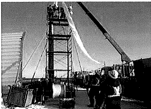
写真-6 現場仮設状況
