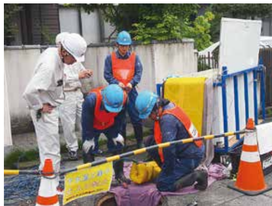
写真-2 高強度ガラスライナー引込作業状況
